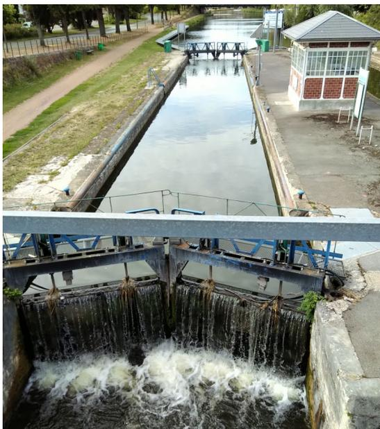
Talvolta le chiuse sono talmente ravvicinate che, all'uscita di una, si vede già l'entrata della successiva. In questo caso le chiuse sono raggruppate in *chaines*, e basta lanciare la manovra della prima: le successive iniziano automaticamente il *bassinage* quando la fotocellula rileva l'uscita dalla chiusa precedente. Non so cosa succeda quando c'è del traffico anche nell'altro senso, ma in queste condizioni, navigando da soli, il sistema funziona benissimo.
